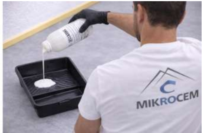
Utilice una charola para pintura
