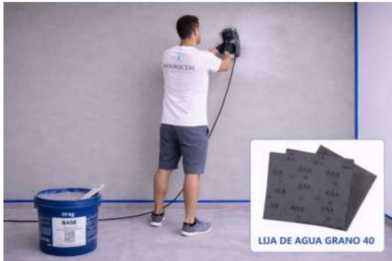
(Lije el microcemento BASE con lija de agua grano 40)
