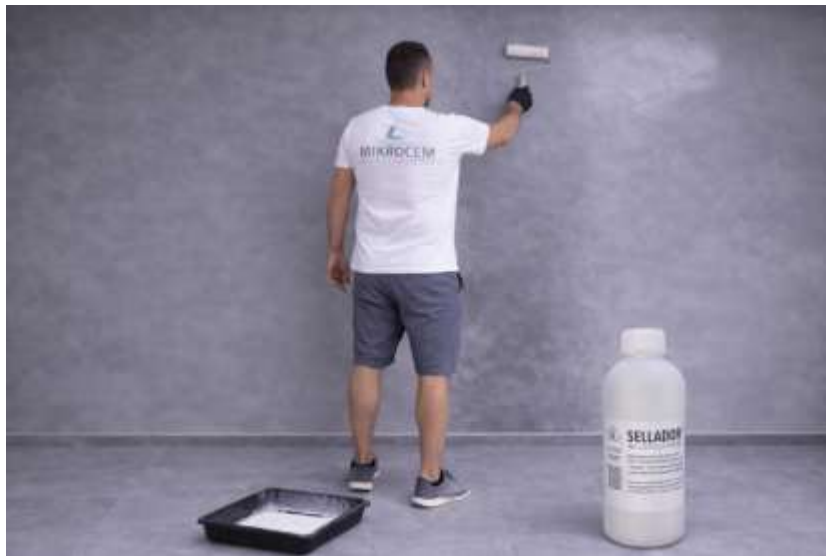
Aplique Sellador por toda la superficie y deje secar
