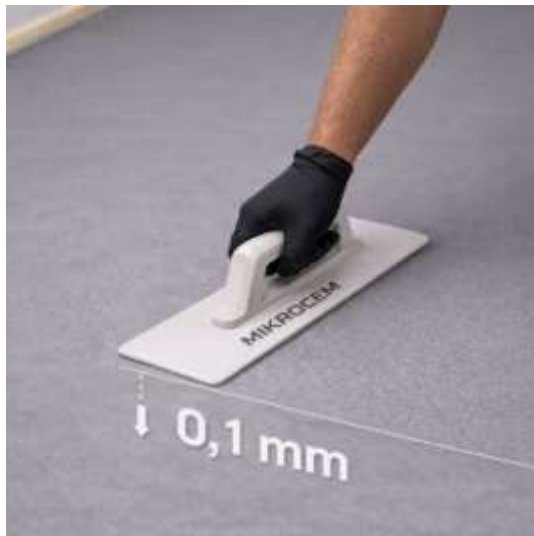
Aplique capas de 0.1 mm de espesor
