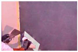
Para una correcta aplicación del Microcemento FINO, es importante limpiar con frecuencia las llanas y las espátulas utilizadas y siempre que el microcemento comience a pegarse a las herramientas. Si no se hace, las capas de FINO quedarán con arañazos y perderán su belleza. Lave regularmente la llana con agua.
