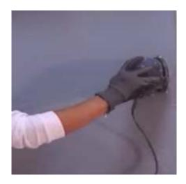
**8. RETIRE EL POLVO CREADO AL LIJAR**: Después de lijar retire el polvo creado con una aspiradora, un trapeador humedecido o un trapo ligeramente húmedo. No abuse del agua en este punto.
