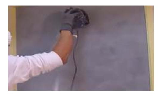
• Después de lijar, retire el polvo creado con una aspiradora, un trapeador humedecido o un trapo ligeramente húmedo. No abuse con el agua, sólo humedezca ligeramente el trapeador o el trapo.
